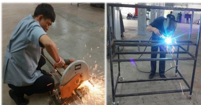
ภาพที่ 3.3 แสดงภาพการตัดเหล็กตามแบบ และการเชื่อมประกอบขึ้นโครงชุดฝึก ฯ
